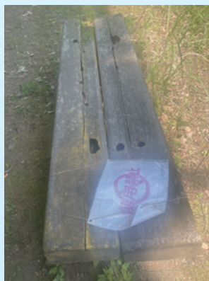
修繕前のベンチ
